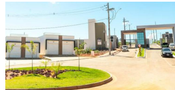
Entrada do empreendimento
